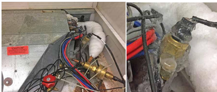
Рисунок 5. Датчики давления серия PX3 компании Honeywell в реальном промышленном холодильном оборудовании.
